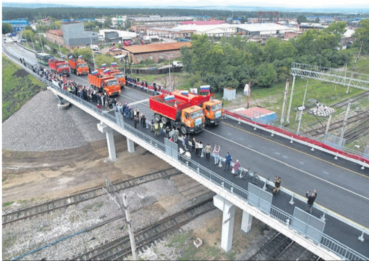
Долгожданный путепровод на станции Батарейная открыли перед началом учебного года.
