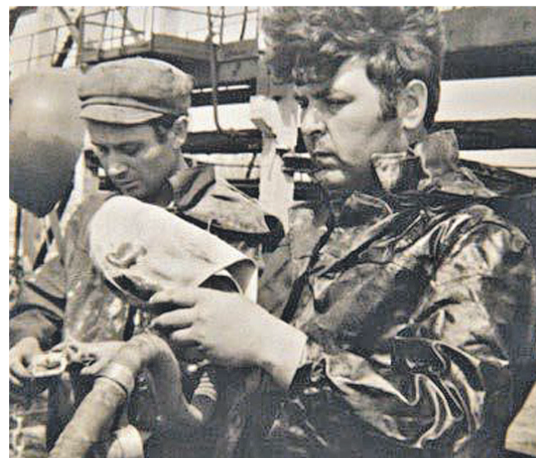
Иосиф Душанек на строительстве ПК «Шесхарис».
