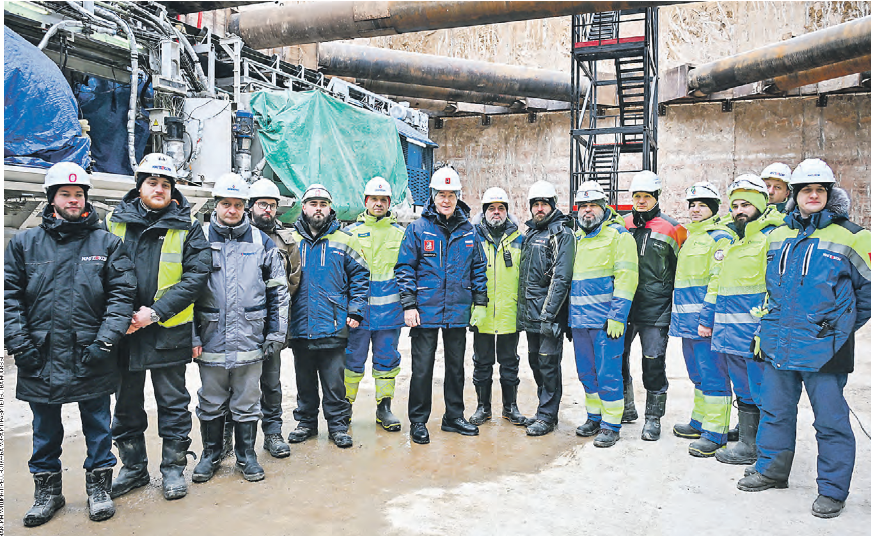
17 февраля. Мэр Москвы Сергей Собянин (в центре) дал старт проходке левого перегонного тоннеля на участке от будущей станции «Рублево-Архангельское» до «Липовой Роши» Рублево-Архангельской линии столичного метрополитена. Сегодня активное строительство ведется на многих участках новой ветки
